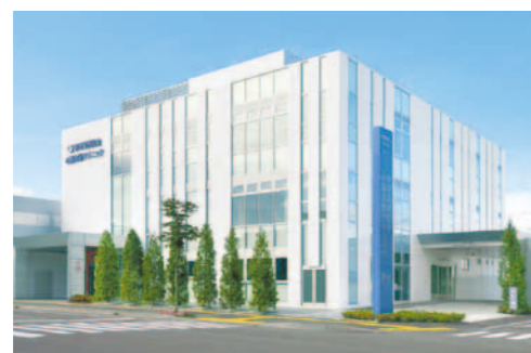
設計：株式会社 DESIGN FIELD 施工：伊藤組土建株式会社
